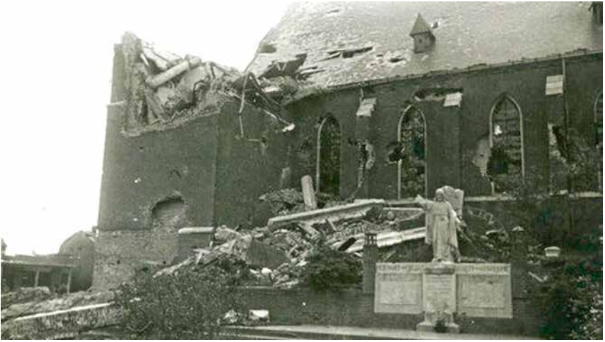
Oorlogsschade aan de Andreaskerk in Velden. Tijdens de Tweede Wereldoorlog werd in 1945 de toren opgeblazen. De rest van de kerk raakte zwaar beschadigd. In de twee volgende jaren werd het kerkgebouw hersteld, maar de toren werd – een geleiding hoger – pas in 1955 herbouwd. Naast de kerk staat een Heilig Hartbeeld uit 1930.
