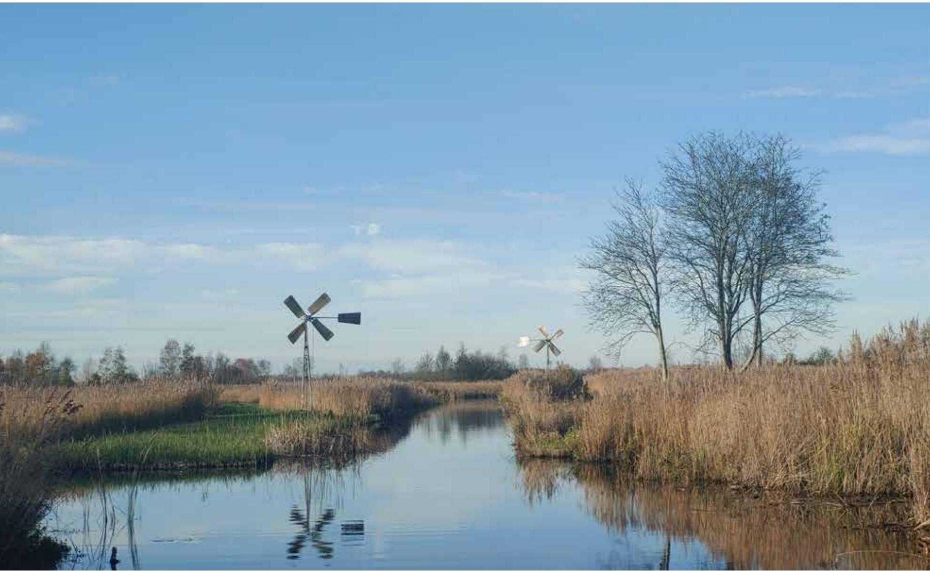
Afbeelding 115. Vooral in De Weerribben staan nog tientallen metalen molens. Ze werden in groten getale ingezet in de jaren '50 toen de grondwaterstand daalde als gevolg van de droogmaking van de Noordoostpolder. Ze pompten het water uit vaarten zoals deze, de Nieuwe Vaart, naar de kraggen die met lage kaden waren omringd. Een aantal molens werkt nog, anderen zijn in verval. Foto Overland.
