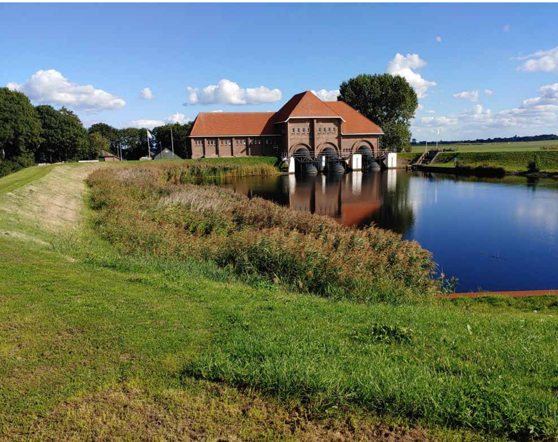
Afbeelding 110. Gemaal A.F. Stroink met op de voorgrond de Ettenlandsche Kolk, die het uitgedompde water naar het Vollenhovermeer leidt. Foto Overland.
