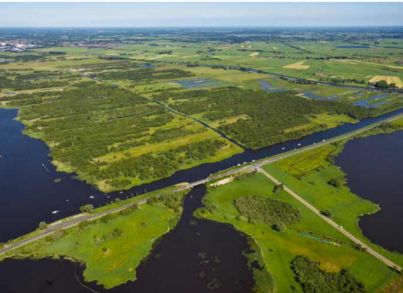
Afbeelding 79. Op deze luchtfoto is goed te zien hoe het de uitgeturfde veenontginningen is vergaan. De Belterwijde (links) en de Schutsloterwijde (rechts) ontstonden net als de grotere Beulakerwijde doordat de smalle ribben die naar vervening overbleven, bij overstromingen zijn weggeslagen. Centraal op de foto zijn de trekgraten dermate verland dat er broekbos kon gaan groeien (zie @@). De beboste stroken centraal op de foto zijn juist weer verlandde petgraten. Daarachter zijn trekgraten te zien die in het kader van het natuurbeheer weer zijn open gemaakt. Van linksachter naar rechtsvoor loopt de Schutsloot waarlangs turf kon worden afgevoerd. Het deel rechtsvoor heeft in de jaren '60 van de vorige eeuw plaats gemaakt voor de Belterweg. Ter hoogte van het dorp Belt-Schutsloot (rechtsonder, buiten beeld) bestaat de Schutsloot nog. Foto: Aerophoto Schiphol.
