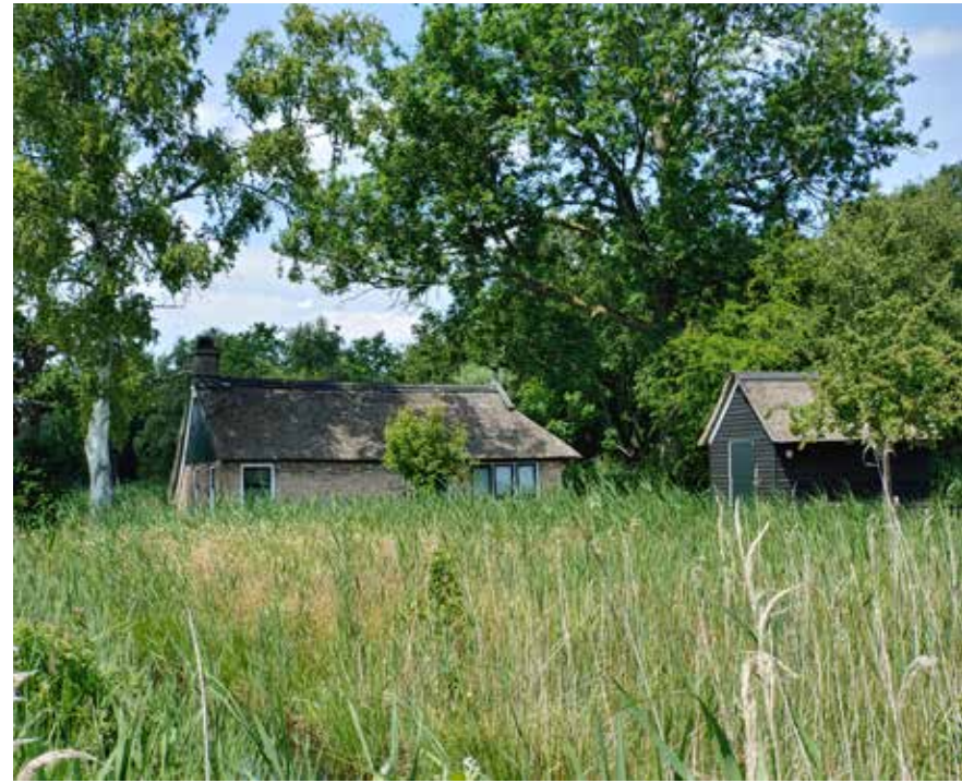
Afbeelding 78. Vooral in De Weerribben zijn nog meerdere kleine verveners-huisjes te zien, vaak met rieten dak, zoals deze aan de Hoogeweg 2 in Kalenberg. Het is nu een rijksmonument. Foto Overland.
