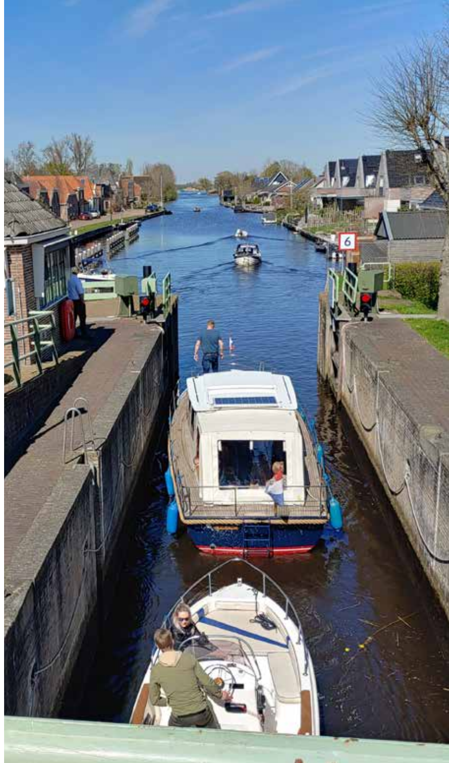
Afbeelding 62. De Arembergersluis is uitgevoerd als schutsluis, zodat schepen kunnen passeren. Tegenwoordig maakt vooral de pleziervaart gebruik van de sluis. Iets verderop liggen de veel grotere sluizen van het Meppelerdiep (de vroegere Sethe). Foto Overland.
