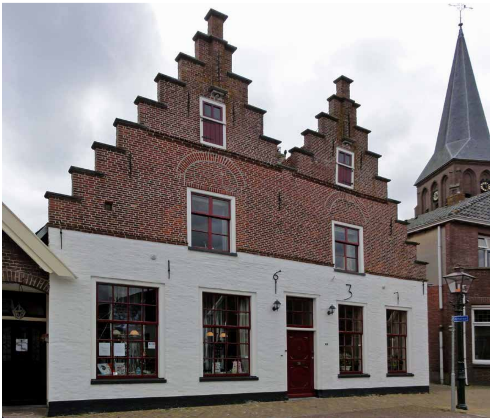
Afbeelding 64. De waag van Oldemarkt is verdwenen, maar dit woonhuis met trapgevel aan de Hoofdstraat herinnert nog aan het handelsverleden. Foto Gouwenaar, Wikimedia Commons.
