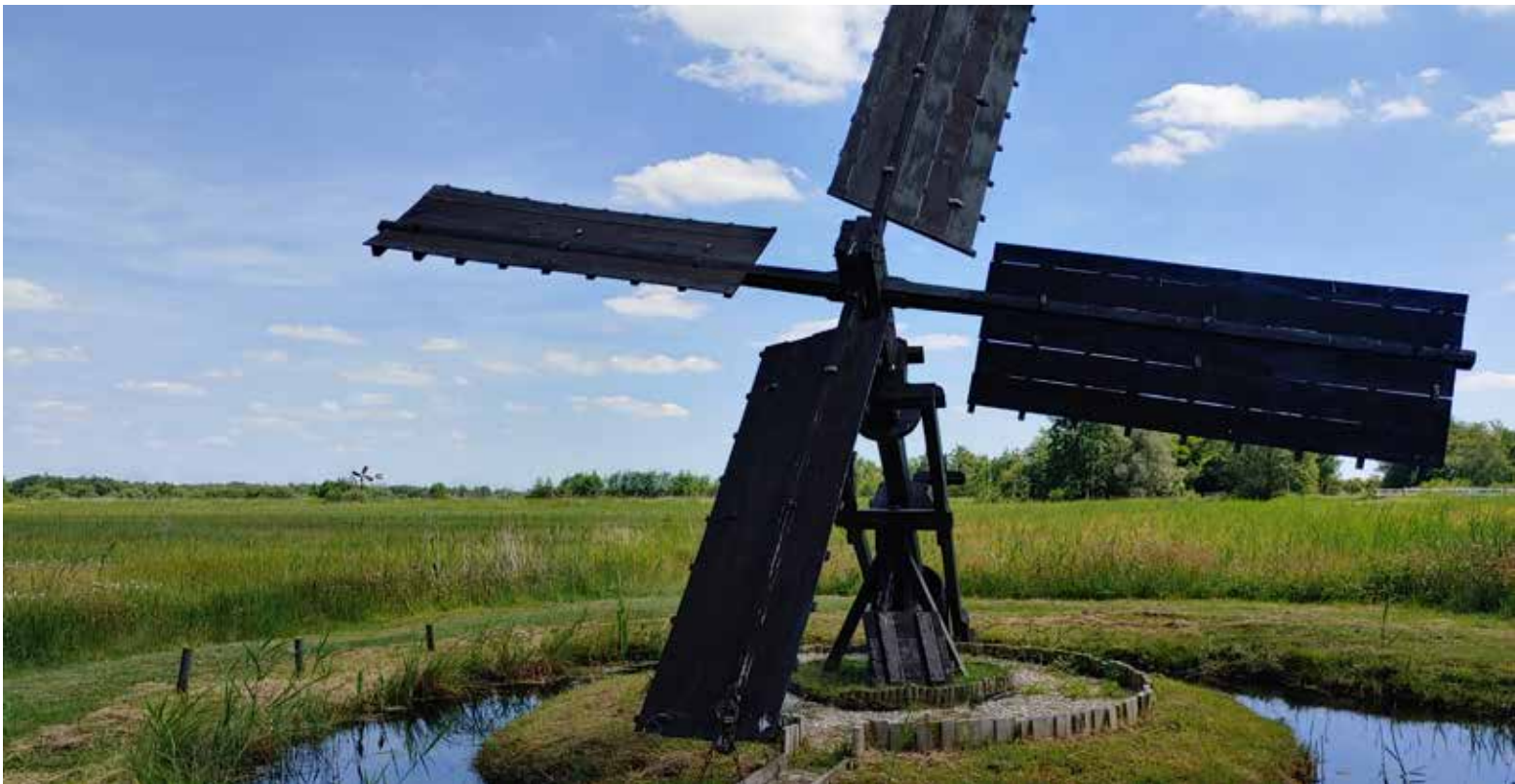
Afbeelding 67. In De Weerribben zijn aan de Hoogeweg, ten noorden van Kalenberg, verschillende typen molens te zien. Zeer algemeen was de tjasker. Ze dienden om in kleine polders een lagere waterstand te bereiken ten opzichte van het boezempeil. Ze deden later ook dienst om de waterstand in af te graven veen te verlagen. Ze werden overbodig door de komst van het A.F. Stroinkgemaal in 1919 en verdwenen daarna uit het landschap. Deze Tjasker is nieuw gebouwd in 1963, als een stukje cultuurhistorie. Iets verderop staat een herbouwde Spinnekopmolen. Foto Overland.
